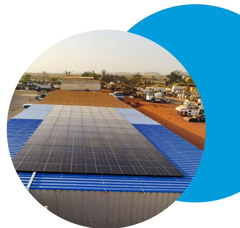
在 Eiffage Sénégal 安装太阳能电池板
